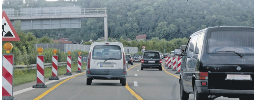
In Deutschland werden die Straßen immer maroder
