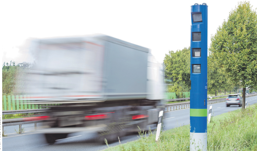
Diese blauen Kontrollsäulen überprüfen zukünftig die Einhaltung der Mautpflicht auf Bundesstraßen.
